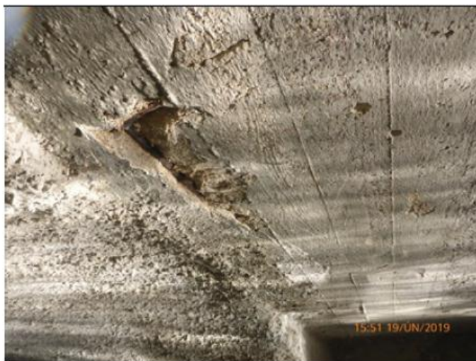
Monolitická dobetonávka mezi nosníky ŽMP 62 a klenbou.
