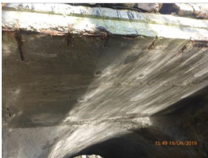
Podhled nosné konstrukce v pravé části mostu. Nosníky ŽMP 62 a monolitická dobetonávka.
